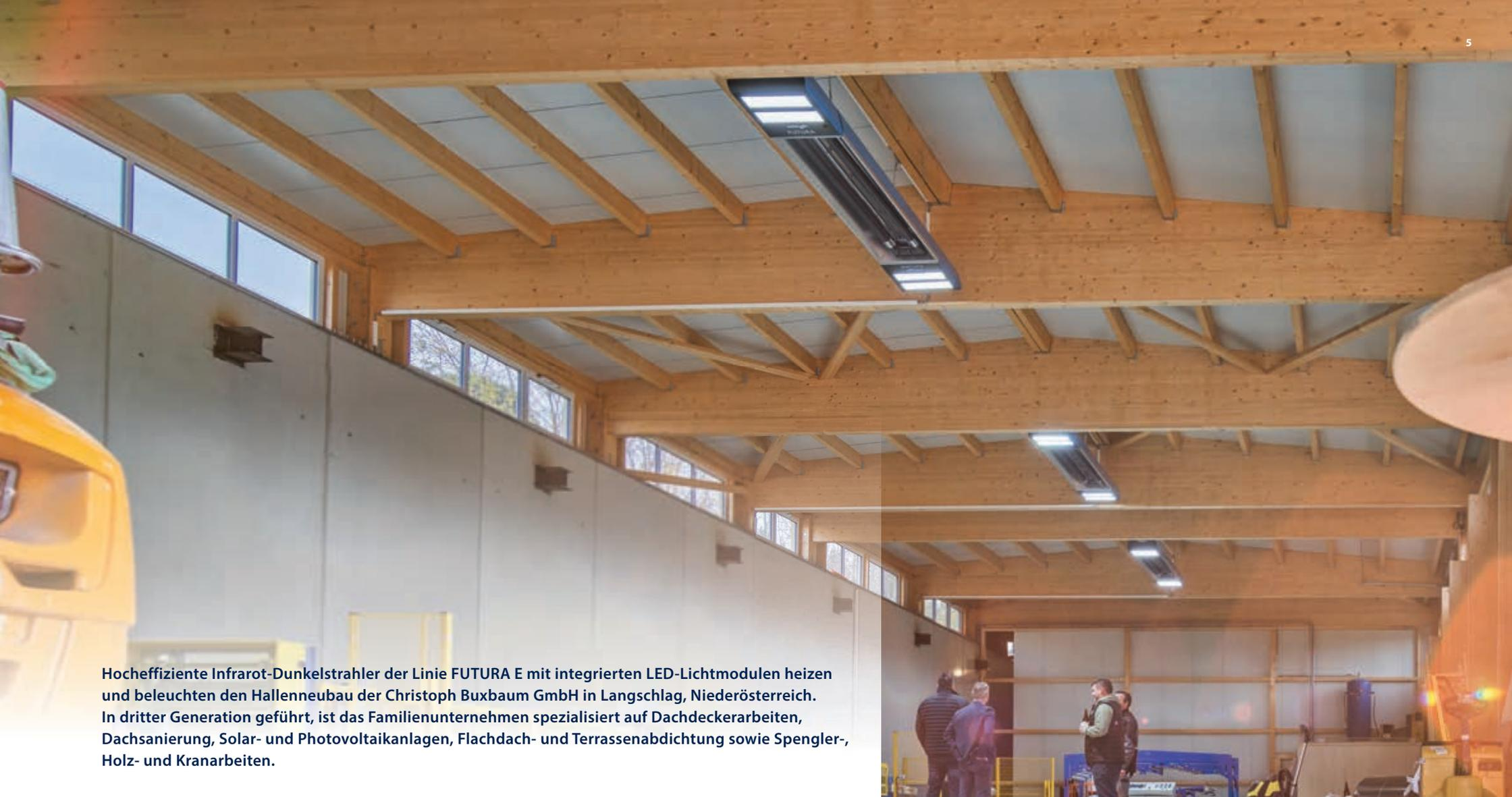
Hocheffiziente Infrarot-Dunkelstrahler der Linie FUTURA E mit integrierten LED-Lichtmodulen heizen und beleuchten den Hallenneubau der Christoph Buxbaum GmbH in Langschlag, Niederösterreich. In dritter Generation geführt, ist das Familienunternehmen spezialisiert auf Dachdeckerarbeiten, Dachsanierung, Solar- und Photovoltaikanlagen, Flachdach- und Terrassenabdichtung sowie Spengler-, Holz- und Kranarbeiten.
